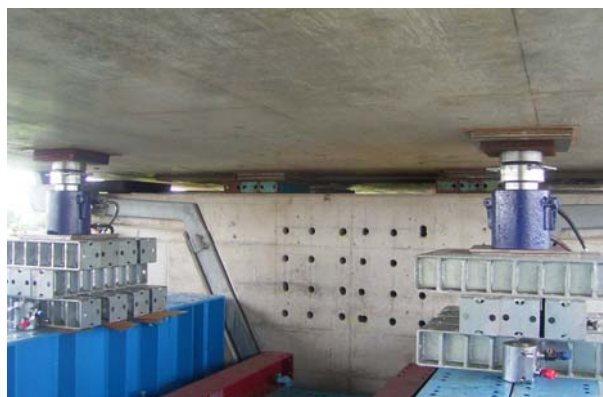
写真-5 鉛直ジャッキ
