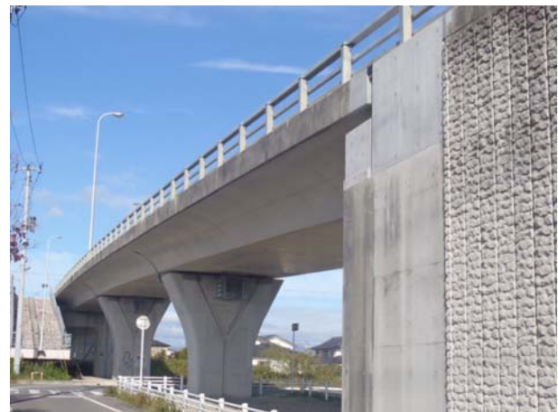
写真-9 復旧完了
