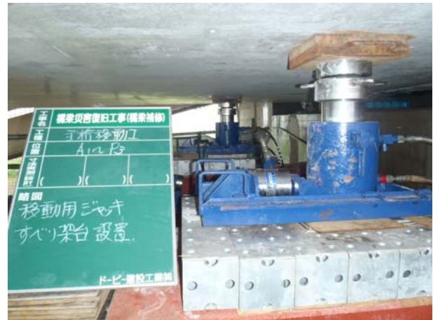
写真-8 スライド装置上の鉛直ジャッキ
