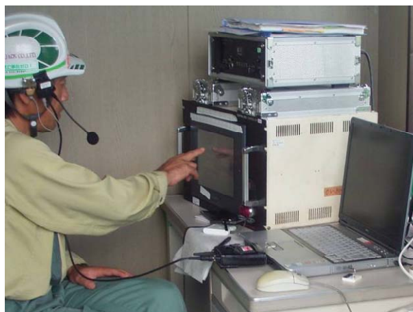
写真-6 中央制御室
