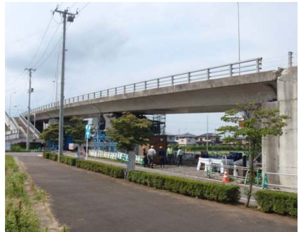
写真-1 笠石高架橋全景
