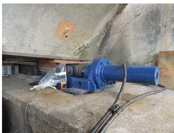
写真-7 スライド装置および水平ジャッキ
