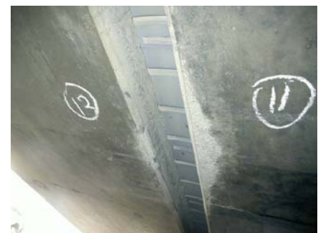
写真-5 断面修復完了
