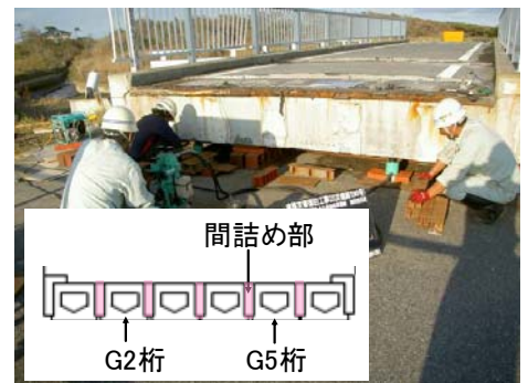
写真-3 ジャッキアップ状況
