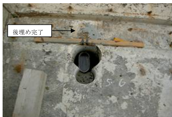
写真-11 アイガスの充てん 「G5 桁-G6 桁間」
