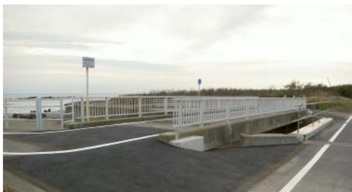
写真-12 復旧完了
