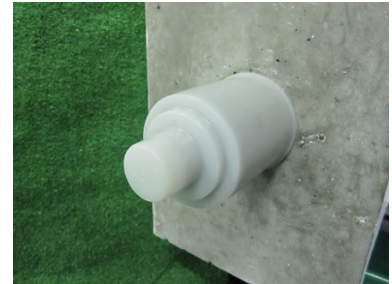
写真-7 定着具保護キャップ取付け状況
