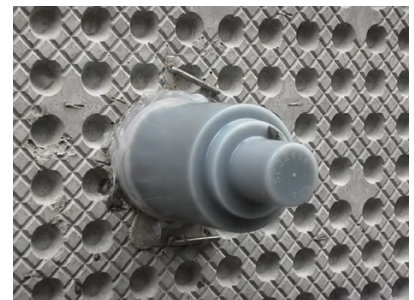
写真-9 現場状況
