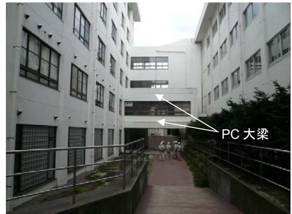
写真-1 解体する渡り廊下部 PC 大梁
