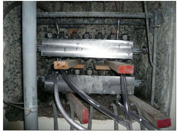
写真-2 中間定着体の設置
