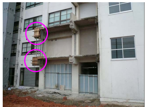
写真-4 解体後の状況
