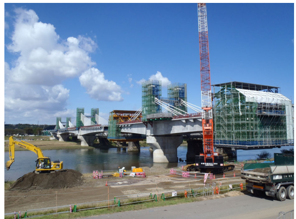
写真-1 張出し施工状況
