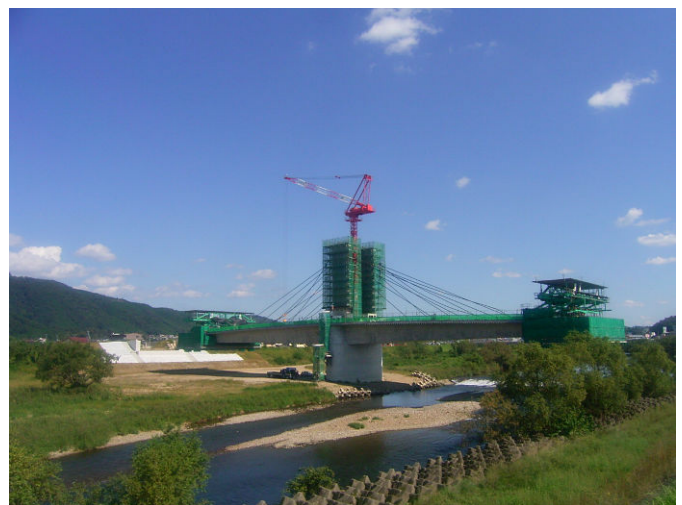
写真-2 ワーゲン設置状況
