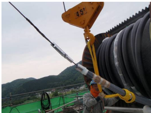
写真-3 斜材ケーブル架設状況 (1)
