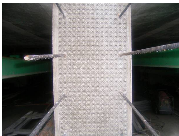
写真-7 コンクリート鉛直打ち継ぎ目処理シートによる粗面処理状況
