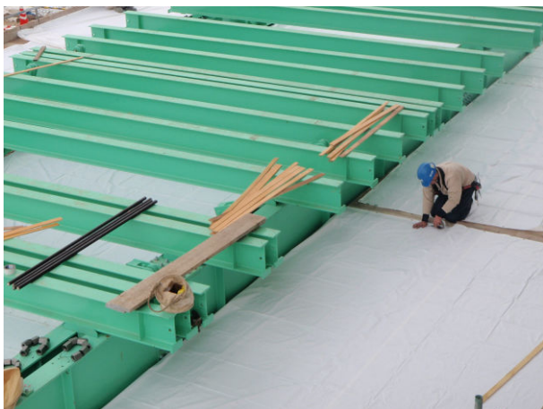
写真-6 防水シート敷設状況
