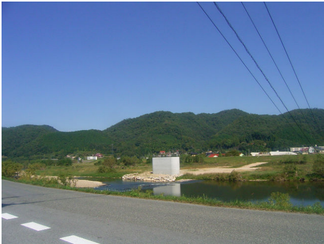
写真-1 上部工着手前状況
