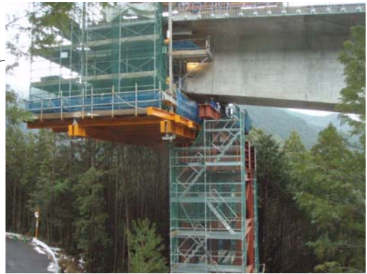
写真-4 ジャッキによる支持状況
