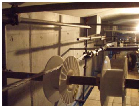
写真-6 外ケーブル引込み状況
