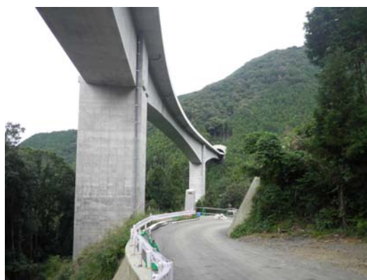
写真-7 施工完了
