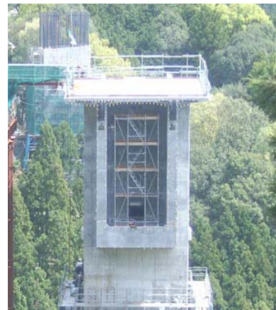
写真-1 柱頭部完成時写真
