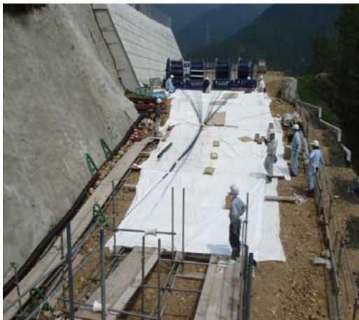
写真-5 外ケーブル組立状況
