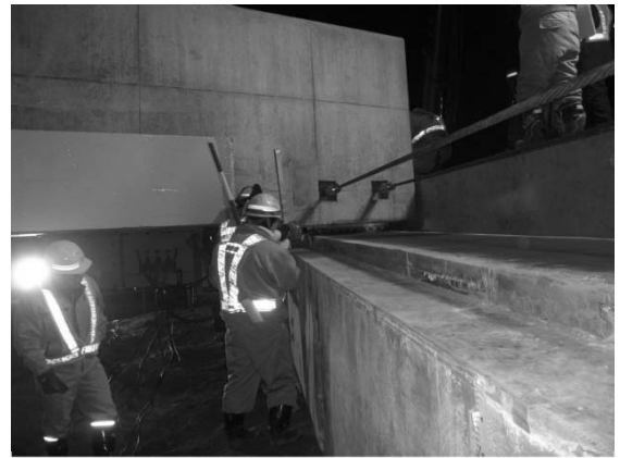
写真-3 牽引中計測状況
