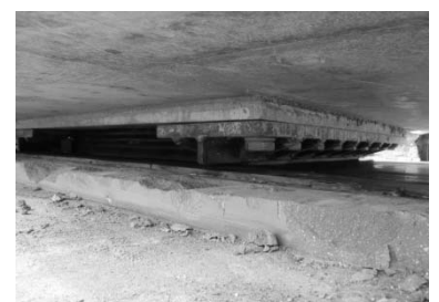
写真-2 すべり支承構造
