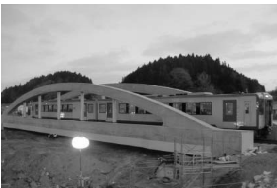
写真-7 横取り架設完了
