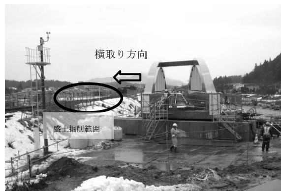
写真-5 横取り架設前全景
