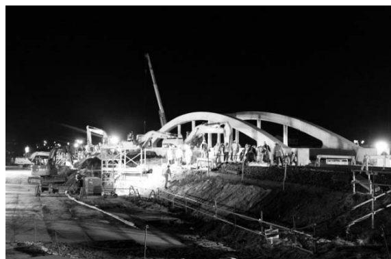
写真-6 盛土掘削状況
