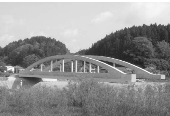
写真-8 夏井川橋りょう完成
