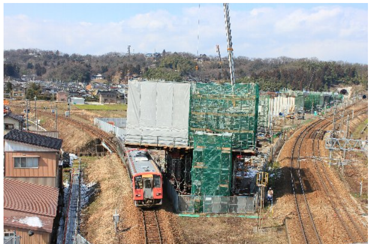
写真-1 柱頭部施工状況
