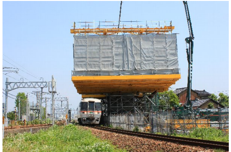
写真-2 超低床型移動作業車による張出し架設状況
