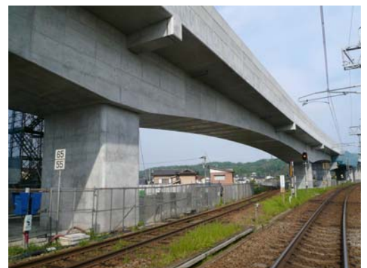
写真-4 主桁施工完了
