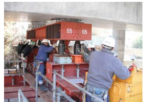
写真-3 仮支柱の解放
