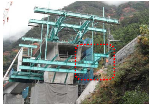
写真-1 移動作業車下横梁の改造
