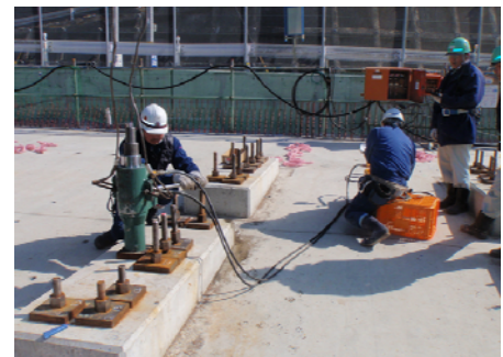
写真-4 仮固定の解放
