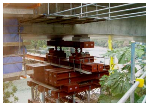
写真-2 桁受け部の構造
