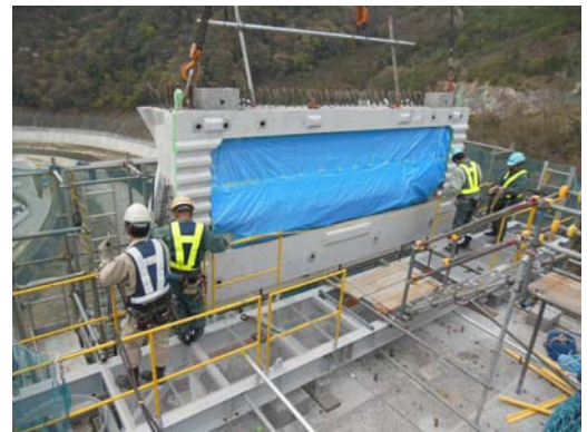
写真-1 セグメント架設状況
