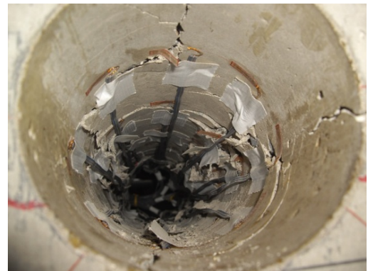
写真-3 試験終了後の供試体 O-1 の円孔内部の破壊状況(A 面側から撮影)
