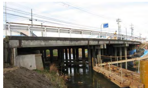
写真-1 橋梁全景(左:A2橋台)
