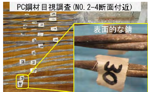
写真-7 鋼材状況
