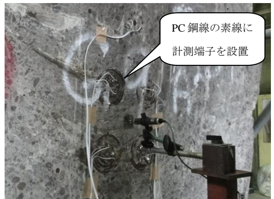
写真-3 電気抵抗計測 (桁端部)
