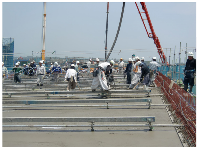
写真－1 橋面仕上げ状況
