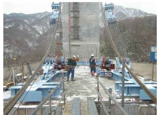
写真-6 2次ロアリング施工状況
