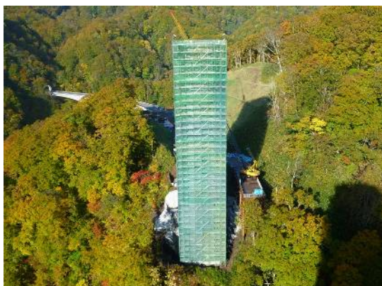
写真-3 足場組立完了(12ブロック施工時)
