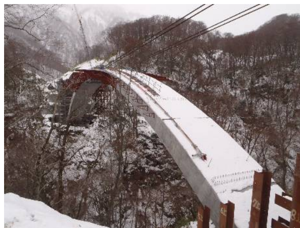
写真-9 ロアリング完了全景
