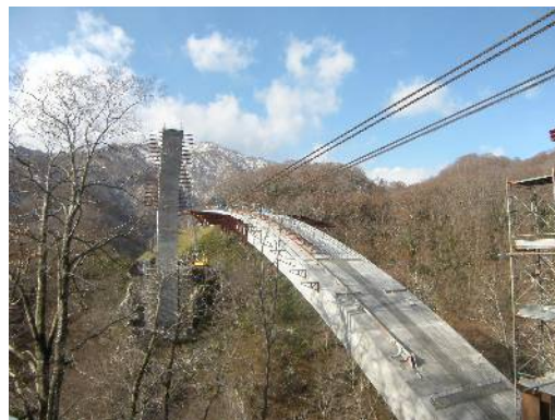
写真-8 4 次ロアリング状況
