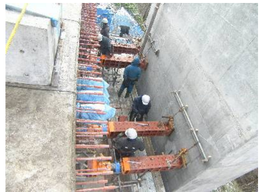
写真-5 1次ロアリング施工状況
