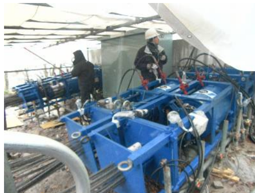
写真-7 ロアリングジャッキ
