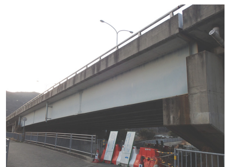
写真 - 1 架橋状況
