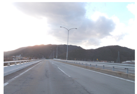
写真 - 2 橋面状況(工事着手前)
