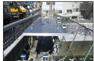
写真-8 アルミ床版の設置
