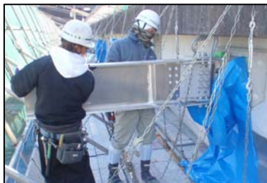
写真-7 ブラケットの設置
