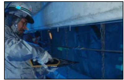
写真-4 エポキシ樹脂の塗布
