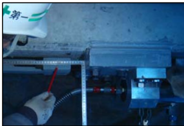
写真-5 炭素繊維プレートの緊張
