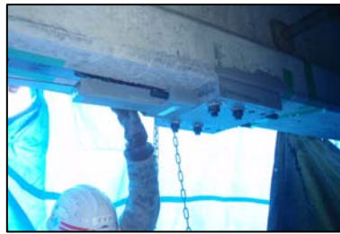
写真-3 炭素繊維プレートの設置
