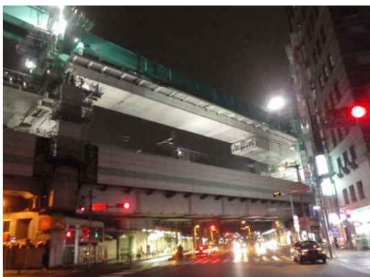
写真-6 Gd1 架設中(走行ガーダー先送り中)
