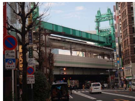
写真-7 Gd1 架設完了状況
