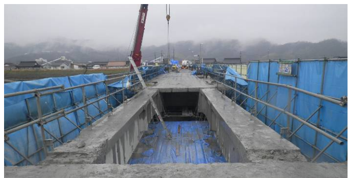
写真-1 橋面工の撤去
