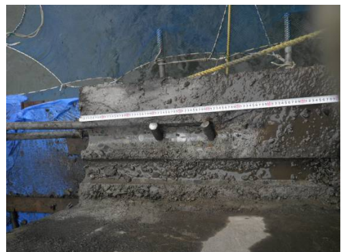
写真-3 固定側アンカー鉄筋の確認
