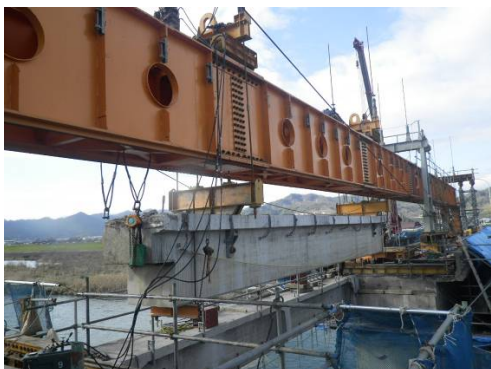
写真-4 架設桁による移動
