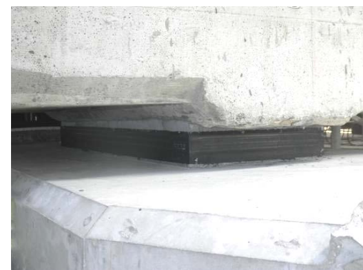
写真-8 支承取替え完了
