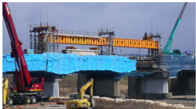
写真-5 橋面上重量台車による移動
