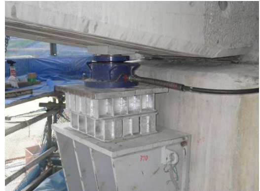
写真-6 ブラケット・ジャッキ設置完了
