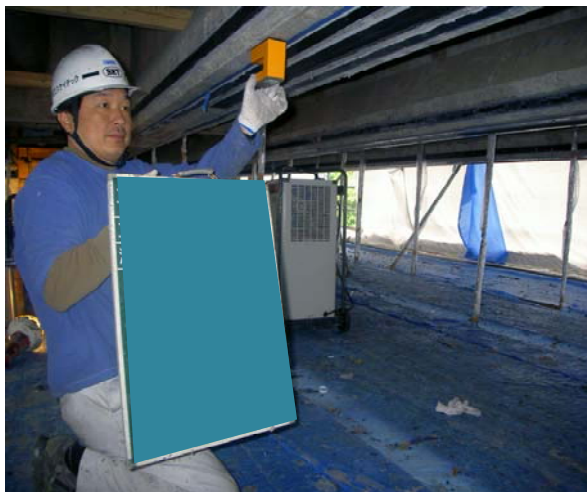
写真-3 高弾性CFRPプレート施工状況
