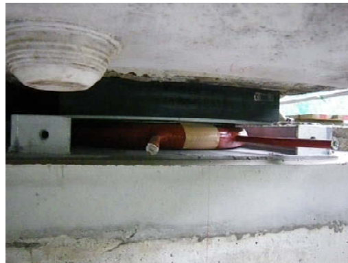
写真-5 モルタル打設前の状況
