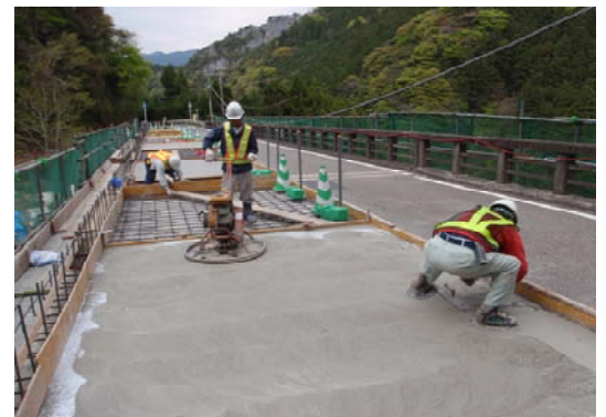
写真-1 上面増厚工の施工状況
