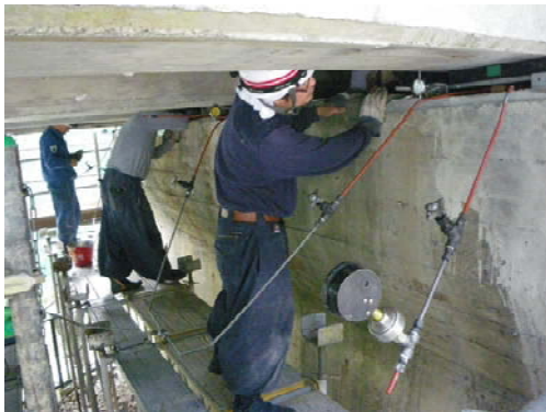
写真-4 フラットジャッキ加圧状況
