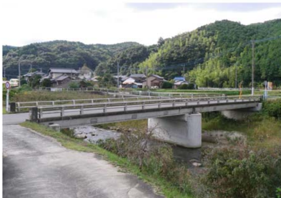
写真-1 既設橋全景
