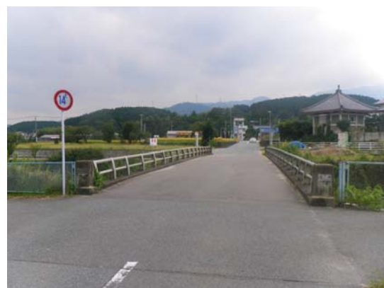
写真-2 既設橋橋面
