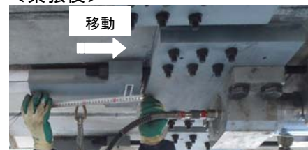
写真-5 緊張状況
