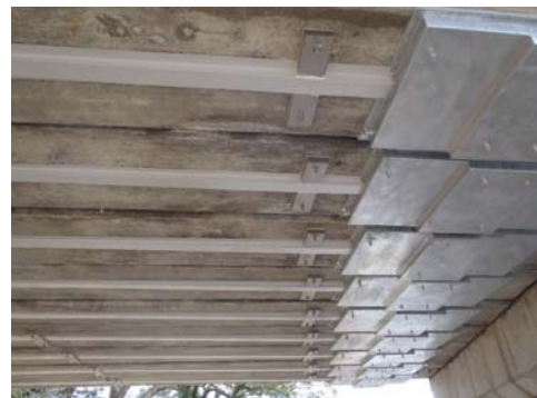
写真－7 完成写真（アウトプレート工法）
