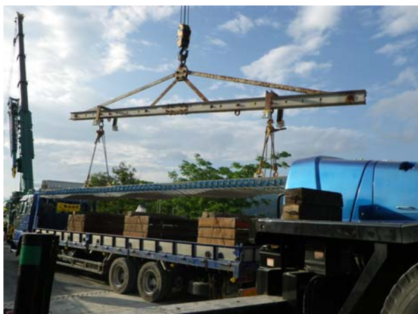
写真-4 15tトラックからの荷受け状況
