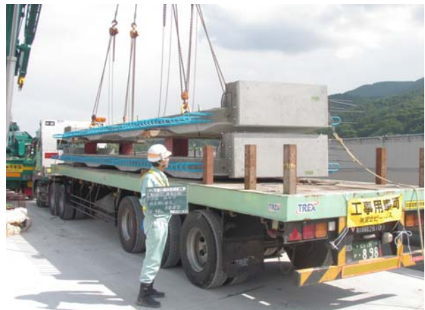
写真-3 120t クレーンによる吊上げ状況
