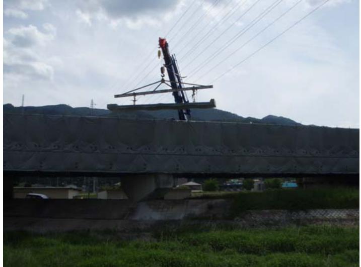
写真-2 吊金具を使用した送電線下の架設
