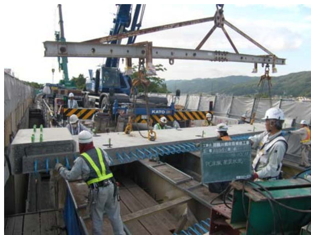
写真-5 プレキャストPC床版架設状況
