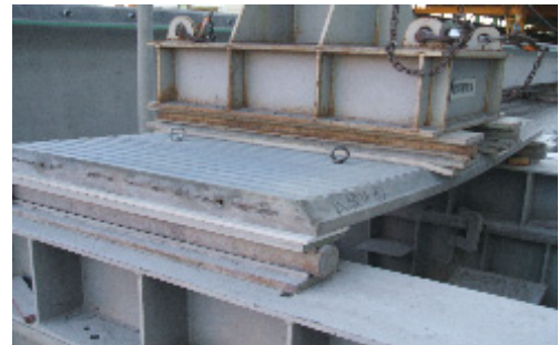
写真-1 PC板の荷重状況
