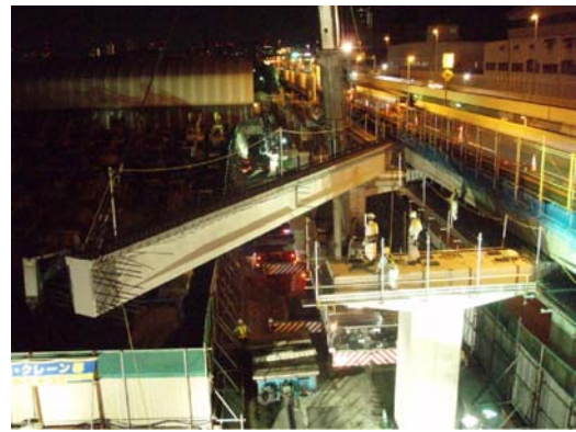
写真-2 主桁架設
