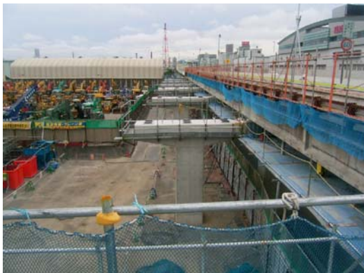
写真-1 既設部材撤去
