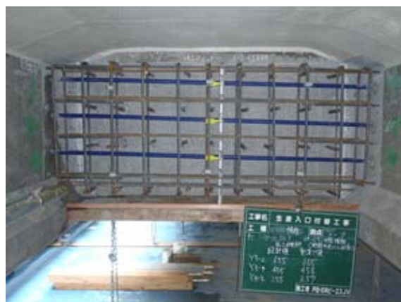
写真-6 既設部中間横桁増厚部の配筋
