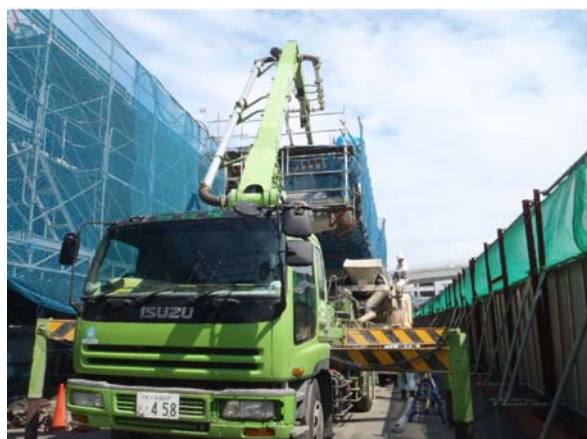
写真-3 床版打設状況
