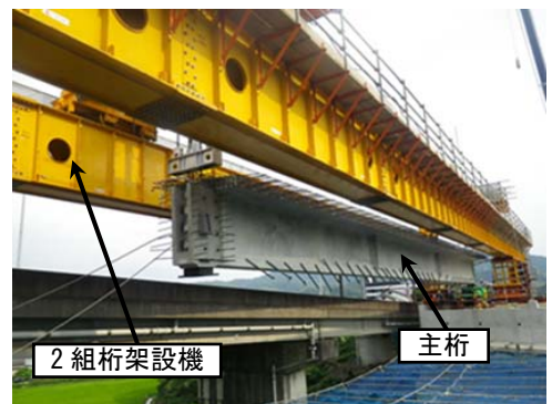
写真-1 主桁架設状況
