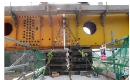
写真-6 架設桁接合部
