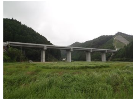
写真-1 完成写真
