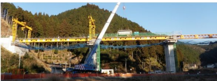
写真-5 架設状況
