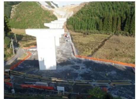
写真-4 ヤード全景
