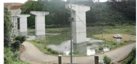
写真-3 橋梁下ヤード(降雨時)
