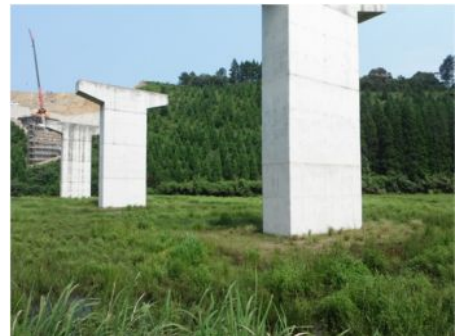
写真-2 橋梁下ヤード(通常時)
