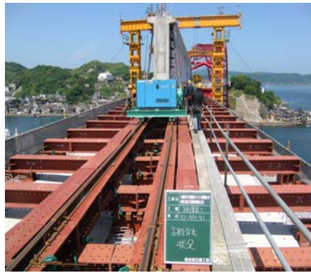
写真-2 主桁引出し状況
