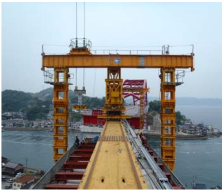
写真-1 架設門構送出し状況
