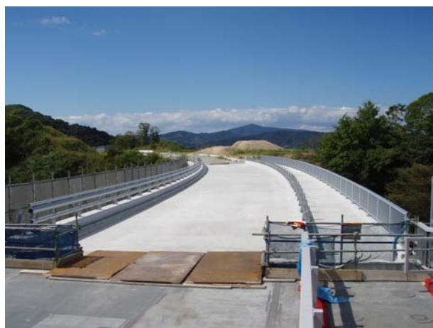
写真－5 音戸側橋梁
