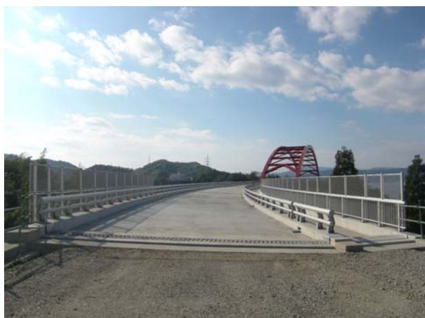
写真－4 警固屋側橋梁
