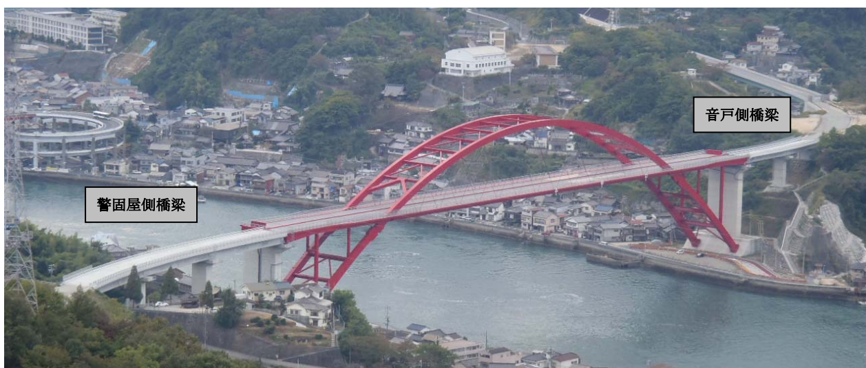
写真－3 第2音戸大橋全景
