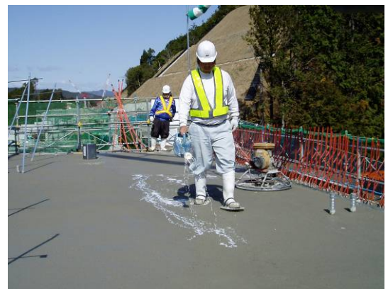
写真-1 打設時の初期皮膜養生剤散布
