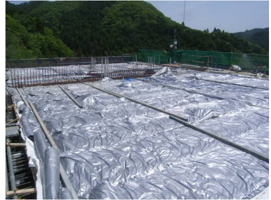
写真-2 打設後の高機能養生マット敷設
