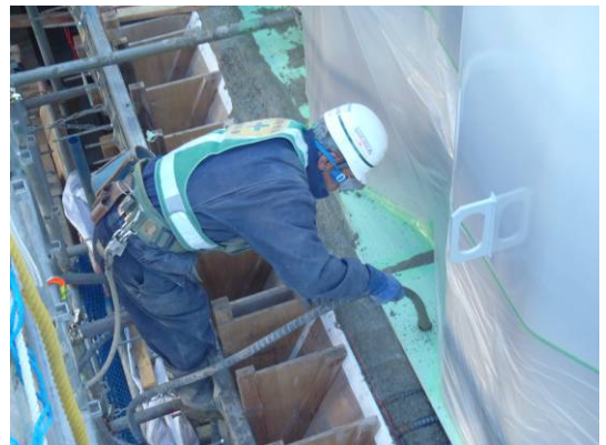
写真-3 空気孔からのバイブレータ挿入
