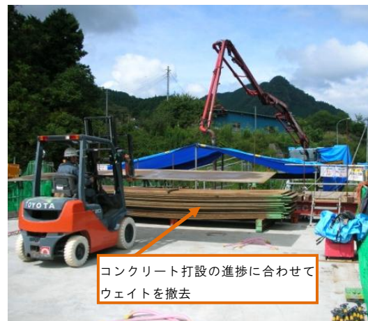
写真-1 コンクリート打設中のウェイト撤去
