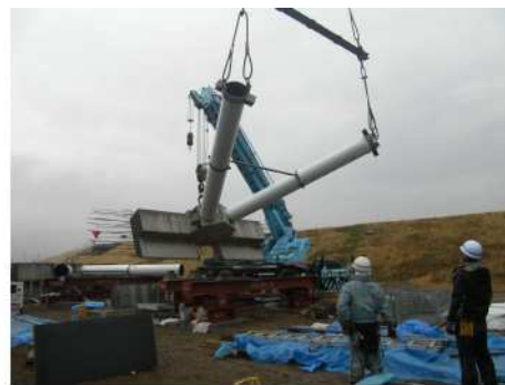
写真-2 セグメント回転状況
