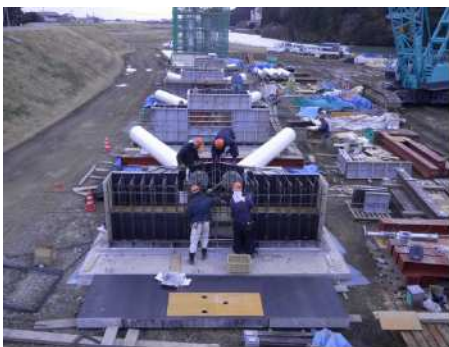
写真-1 セグメント組立状況
