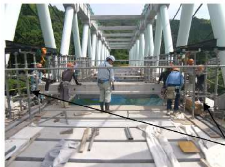
写真-4 PC桁架設状況
