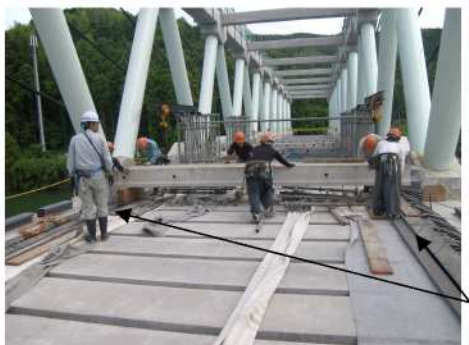
写真-3 PC桁搬入状況
