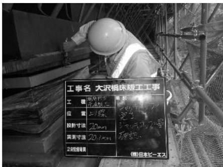
写真-3 ジャッキアップ量測定状況
