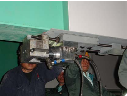
写真-3 緊張作業状況
