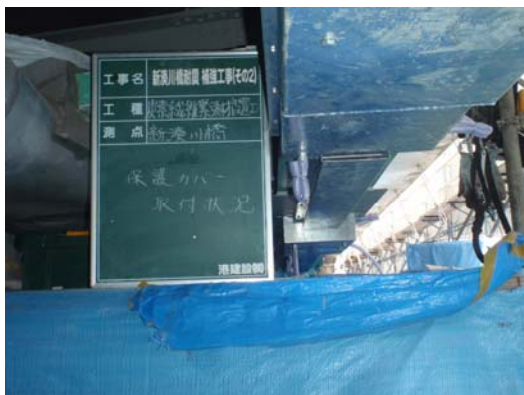
写真-5 保護カバーの設置およびグラウト完了
