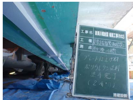
写真-6 ポリウレタン塗装による仕上げ
