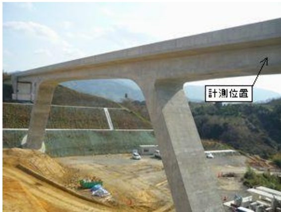
写真 - 1 実橋のひずみ計測位置
