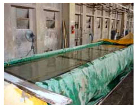
写真-2 水中養生状況
