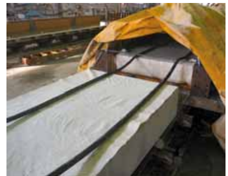
写真-1 散水養生状況
