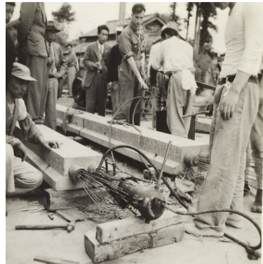
写真-2 緊張状況
