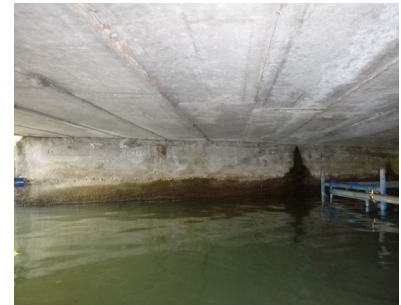
写真-3 桁下状況
