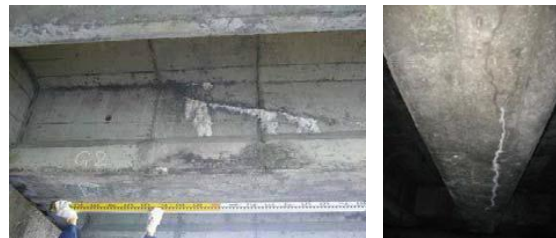
写真-2 撤去前の外観変状
