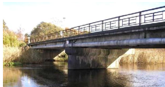
写真-1 対象橋梁の全景(上流側より撮影)
