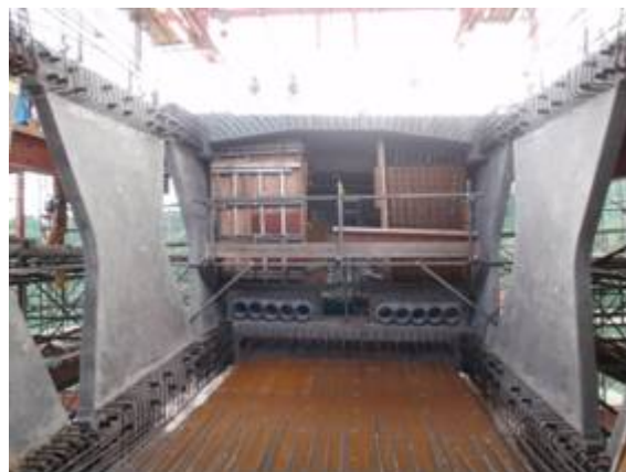
写真-6 中央閉合部のバタフライウェブ架設状況
