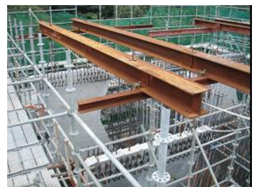
写真-2 柱頭部のパネル架設状況
