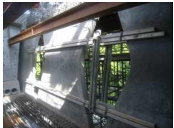
写真-5 パネルの方向・傾きの調整
