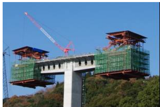
写真-3 張出し施工状況
