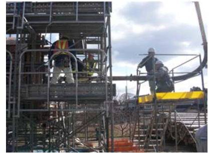
写真-2 妻型枠開口打設状況
