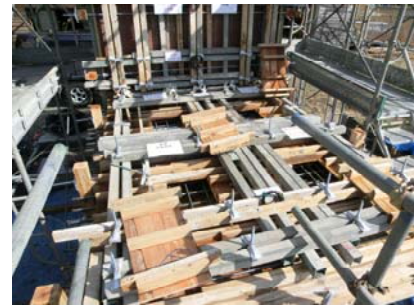
写真-1 下床版伏型枠
