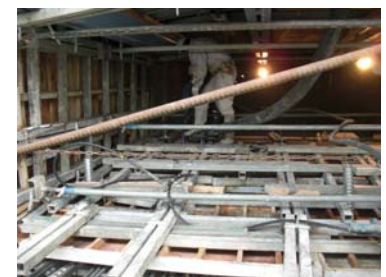
写真-4 下床版打設状況
