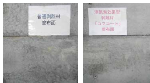
写真-6 ウェブ側面仕上がり状況
