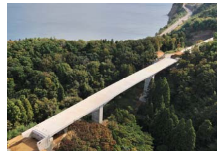
写真-7 架設完了全景
