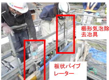
写真-5 ウェブ仕上げ状況
