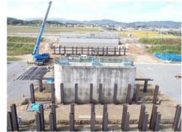
写真-6 継ぎ杭施工
