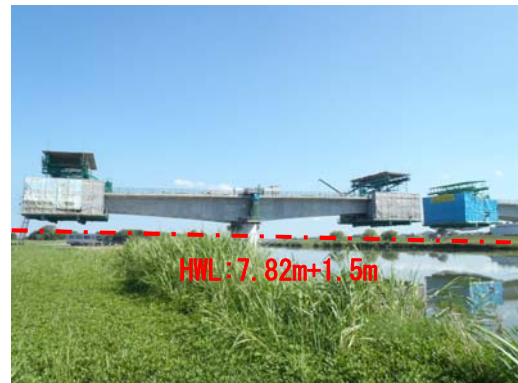
写真-2 張出施工状況
