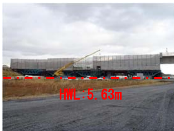
写真-4 側径間支保工
