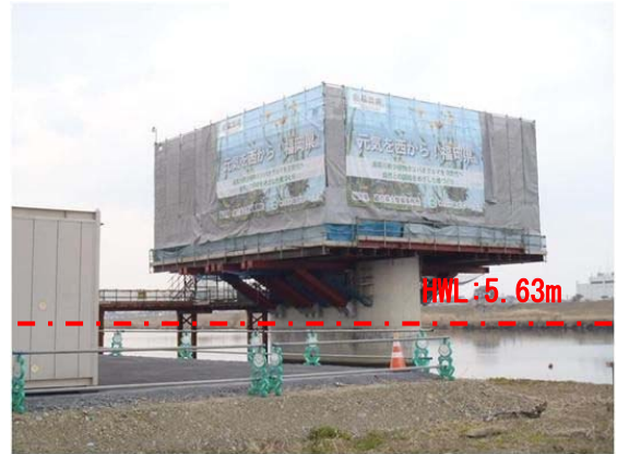
写真-1 柱頭部支保工
