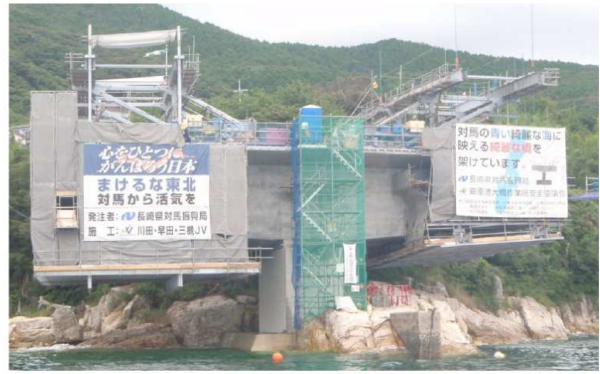
写真-6 P2張出し施工
