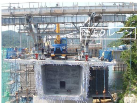
写真-4 クレーン設置
