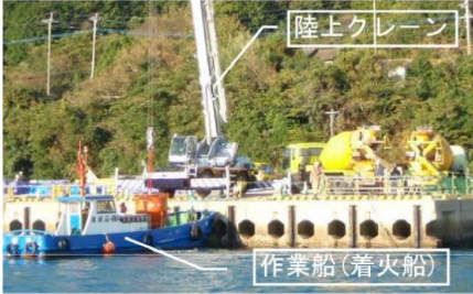
写真-1 生コン積み替え
