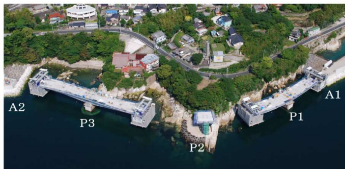
写真-5 張出し施工全景
