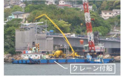
写真-3 海上打設
