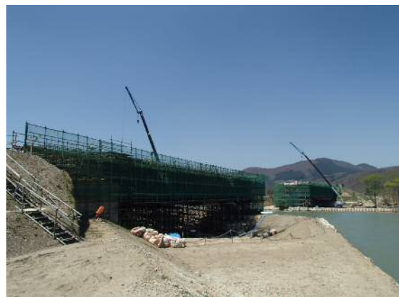
写真－3 2014年4月1日現在施工状況 A2側よりA1側を望む
