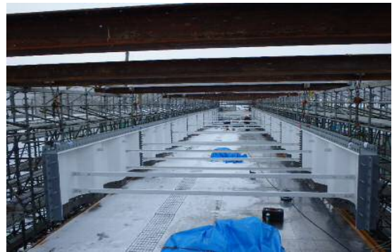
写真－1 波形鋼板ウェブ設置状況 (A2よりP2を望む)
