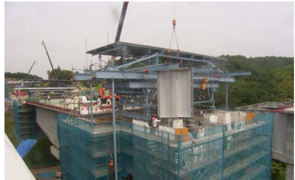
写真-4 波形鋼板架設状況
