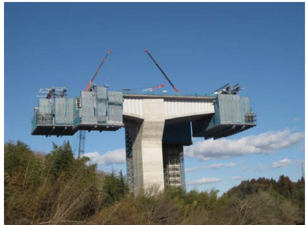
写真-3 下りP2の張出し施工状況
