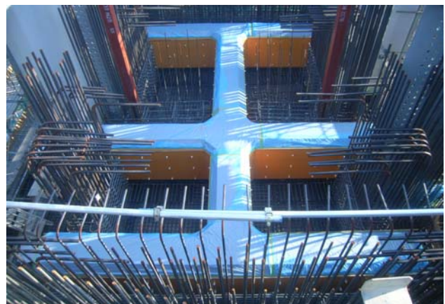
写真-1 柱頭部横桁人通孔(型枠組立て時)
