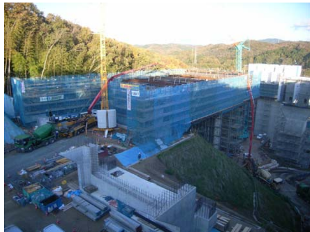
写真-2 支保工部コンクリート打設状況
