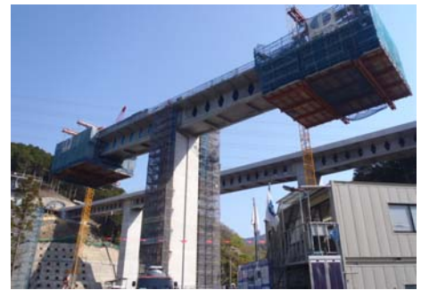
写真-4 張出し施工状況
