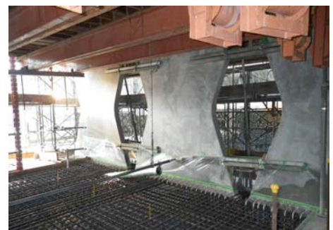
写真-6 ウェブパネル設置完了
