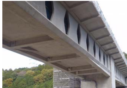
写真-3 下床版近景
