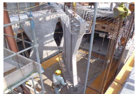
写真-5 ウェブパネル架設状況
