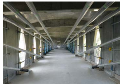
写真-2 主桁内部
