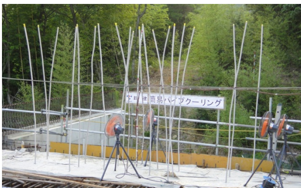
写真-1 ヒートパイプによるパイプクーリング状況
