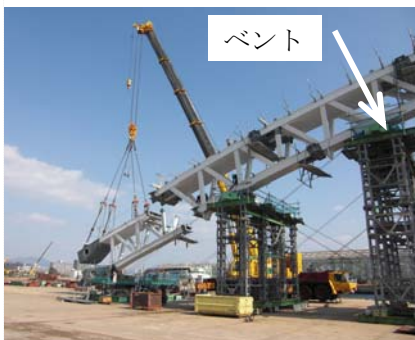
写真-1 地組立て状況
