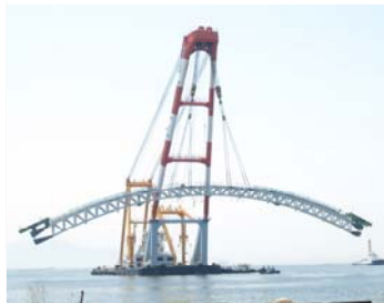
写真-4 水切り状況
