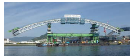
写真-5 台船架台状況
