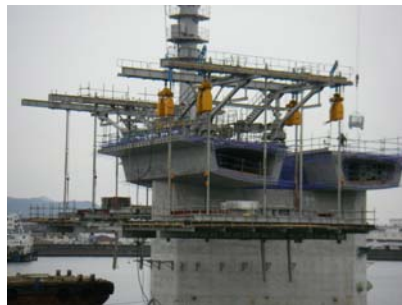
写真-2 吊り上げ状況
