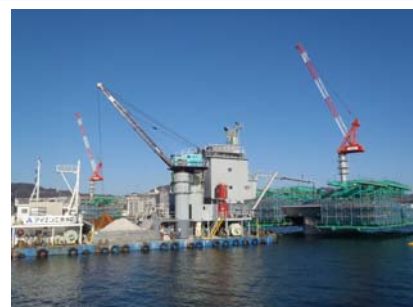
写真-4 CP船打設
