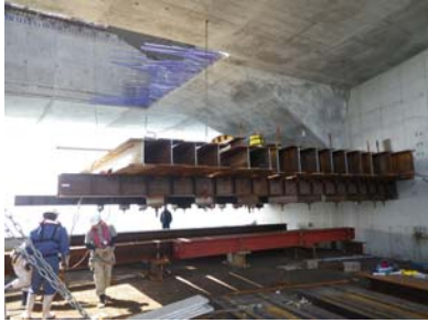
写真-6 フィン支保工横移動
