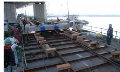
写真-3 構台上セグメント縦移動
