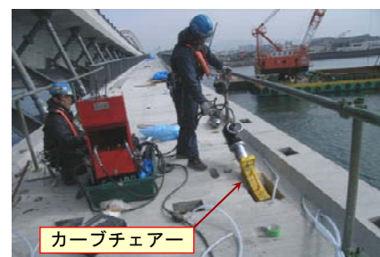
写真-4 閉合ケーブル緊張状況
