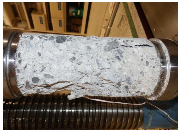
写真-2 ひび割れ発生状況
