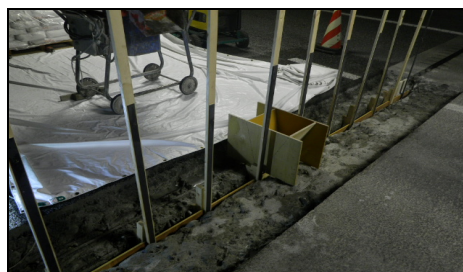
写真-8 型枠組立て完了
