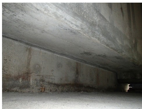
写真-9 補修完了後（横桁下面）
