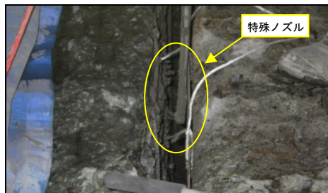
写真-7 鉄筋防錆材塗布状況
