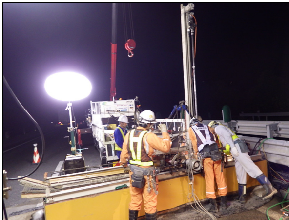
写真-6 WJはつり状況
